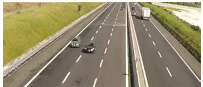
2A e 2B. Le pavimentazioni rilevate in A1 (2A) e in A1 dir (2B)
